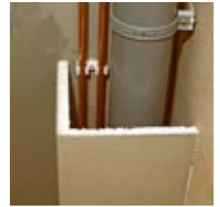
Zeer eenvoudig wegwerken van leidingen en afvoeren.
